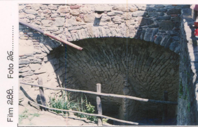
p.v. N. ... Il punto di passaggio dell'acqua del botaccio alle pale
