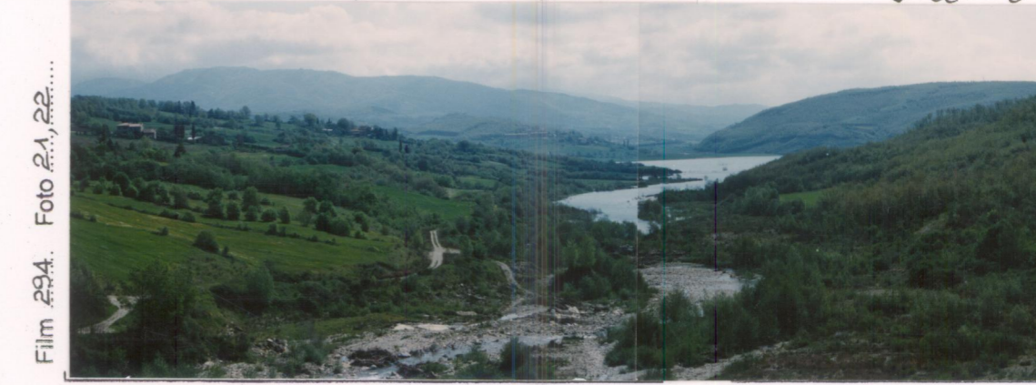
p.v. N. ... Dal ponte sul Singerna verso la bassa valle del Singerna che diventerà il braccio ovest del Montedoglio
