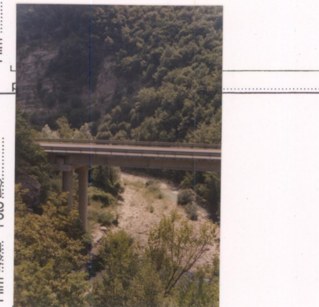
p.v. N. La EAS che scavalca il Tevere presso Fabronciano
