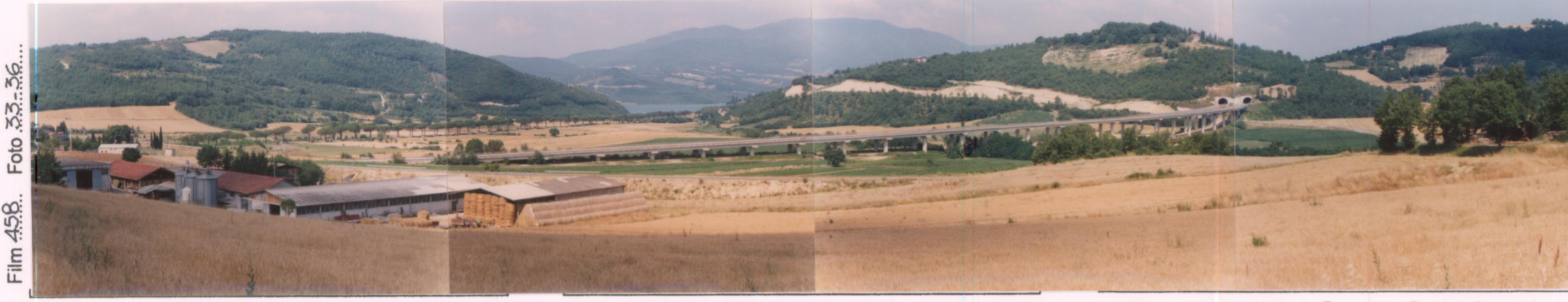
p.v. N. .... Da Carsidonio verso la bassa valle del Tignano con il viadotto della E45 che attraversa il torrente La E45 e poi in galleria sotto Poggio delle Buiane. A sinistra il monte di pini della statale Tiberina che sarà sommersa dalle acque dell'invaso di Montedoglio, e a destra il taglio della strada nuova sul Poggio delle Buiane.
