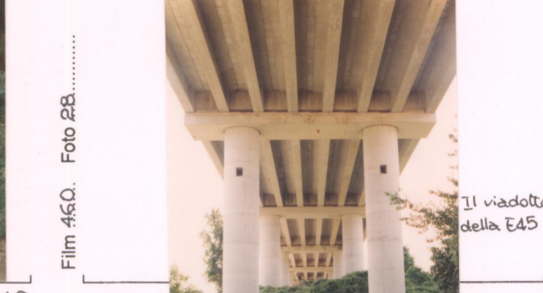
p.v. N. .... Il viadotto della E45
