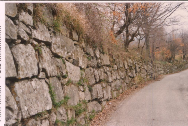
p.v. N. Muro di sostegno lungo la strada di accesso
