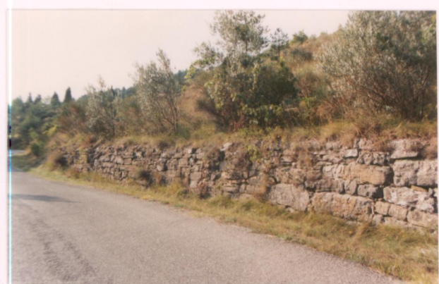
p.v. N. Muro di sostegno lungo la strada di Montecasale
