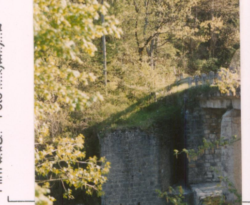
Film 288. Foto 24, 23, 22. Il ponte sul Marecchia della strada S. Patrignana - Pofello.
