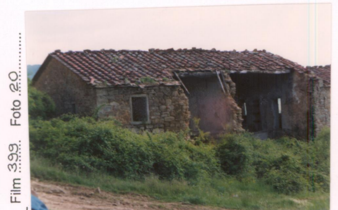
p.v. N. Rudere di abitazione rurale sul crinale Poggio Castiglione - S. Veniano.
