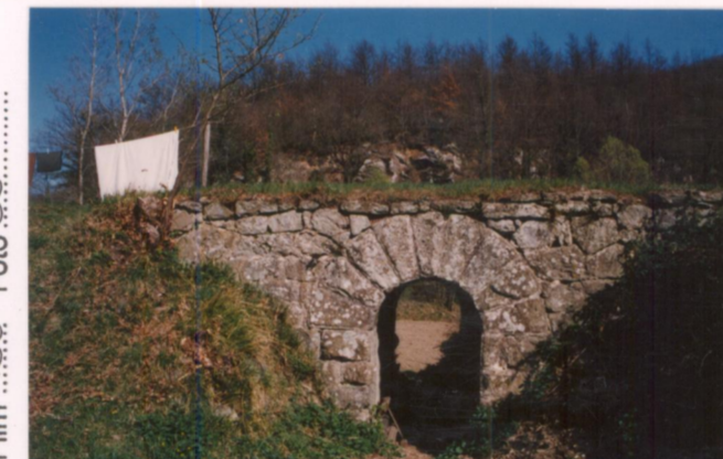
p.v. N. Ex ponte ferroviario presso Pieve a Ranca
