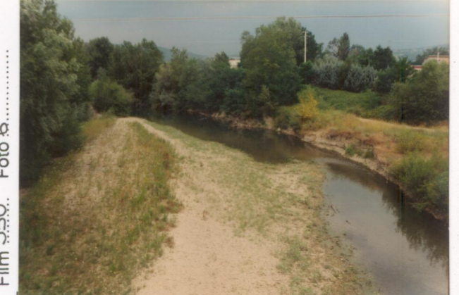
p.v. N. Dal ponte sul Tevere verso sud
