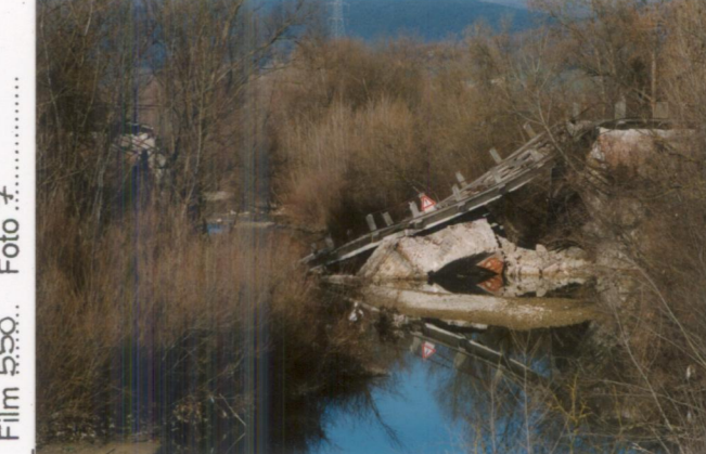
p.v. N. Dal ponte verso il Tevere a nord: il vecchio ponte crollato recentemente
