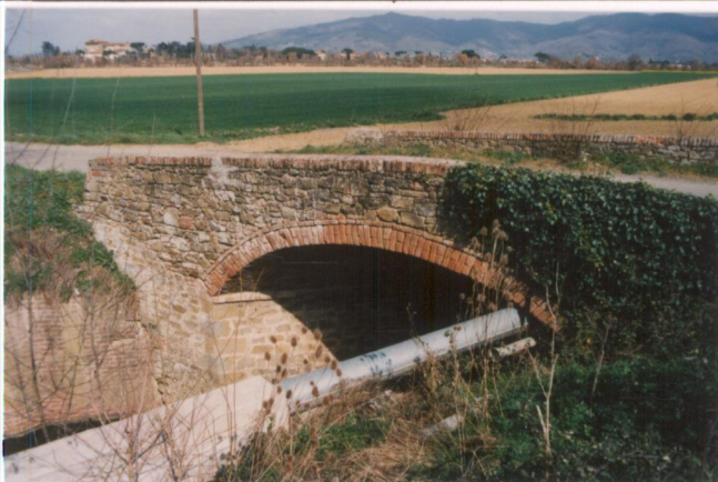
p.v. N. 26: ponte su str. di Topgia Ciliegia
