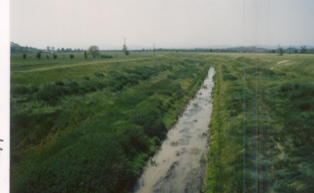
p.v. N. 33 : Canale Maestra presso Ponte di Cortona
