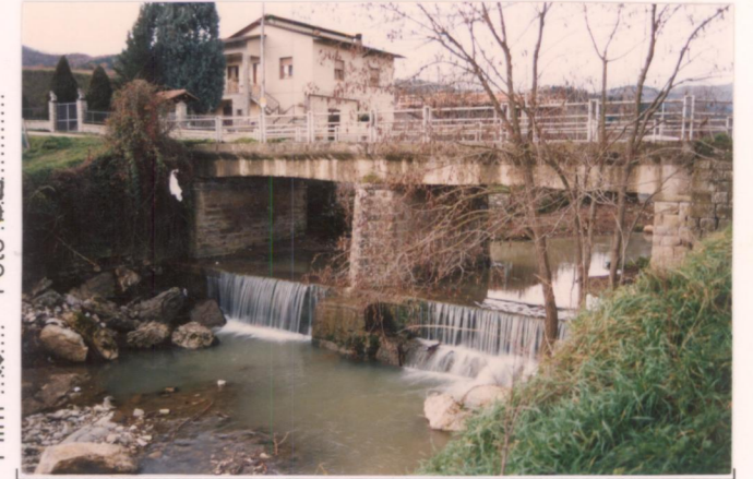
p.v. N. 10. Ponte della strada di accesso, sul torrente Soligine
