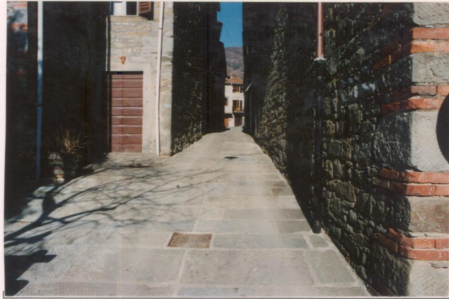
p.v. N. 8. via interna lastricata.....
