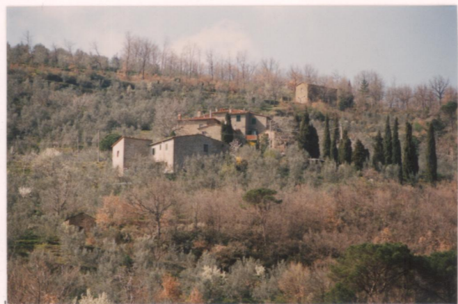
p.v. N. 21 edifici...lungo la strada...per Poggio di Loro
