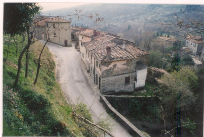
p.v. N. 3. veduta dagli edifici a monte .....
