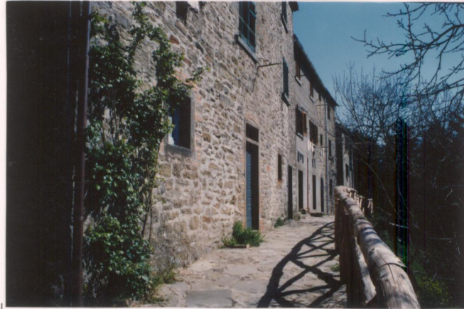
p.v. N. 11. percorso di bordo sul fronte sud
