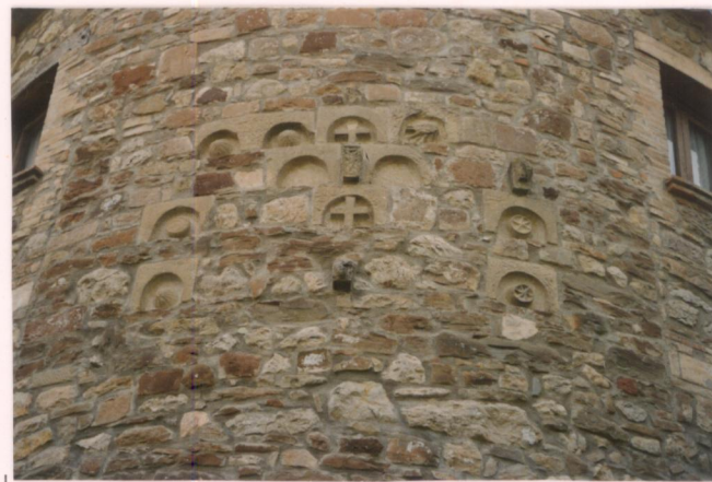
p.v. N.11. Particolare dell'abside della chiesa
