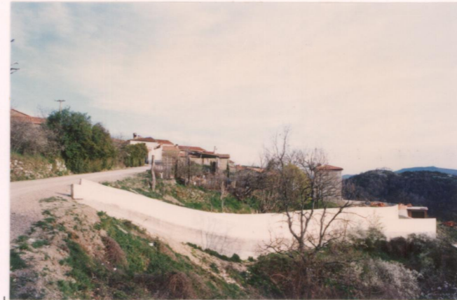
p.v. N. 9.. Muri di contenimento a sud-ovest.....
