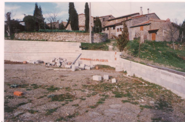
p.v. N. 10.. Lato sud-ovest dell'aggregato.....
