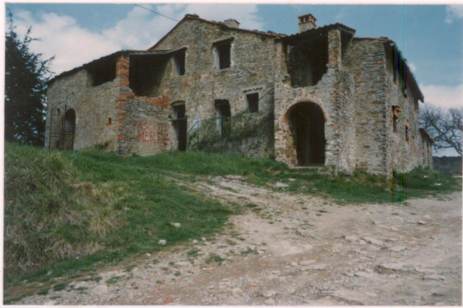
p.v. N. 11 Casa rurale abbandonata tra S. Severo e Poggio dei Vecchi
