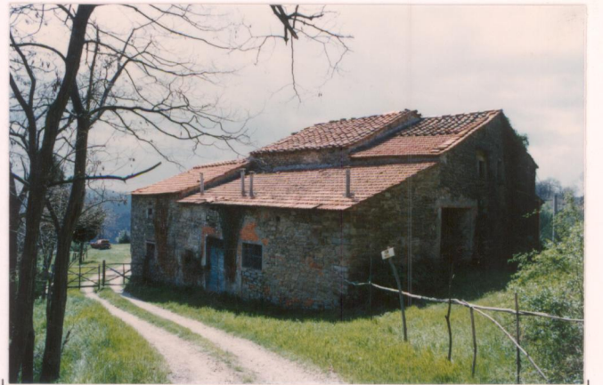
p.v. N. 10 Edificio non dismesso.....
