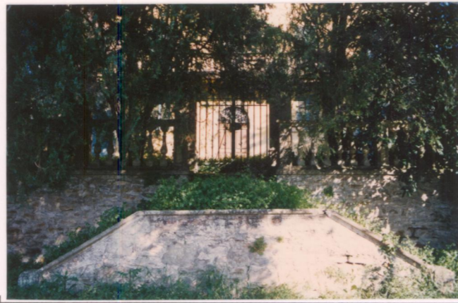
p.v. N. 8. L'ingresso dismesso.....
