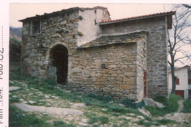
p.v. N. 6... Sulla destra, aggiunte edilizie recenti
