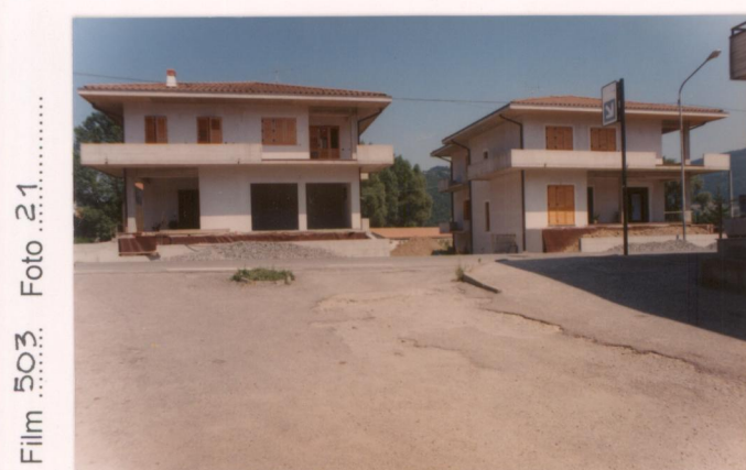
p.v. N. 18 Edificazioni recenti
