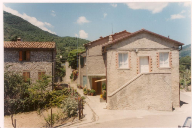
p.v. N. 18 Interventi di ristrutturazione edilizia
