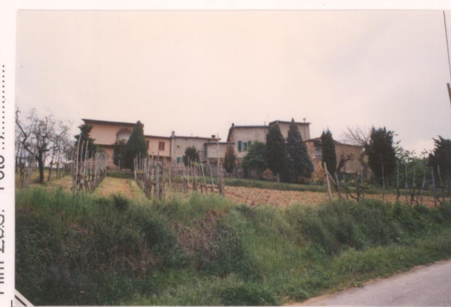
p.v. N. 2. Veduta dalla strada
