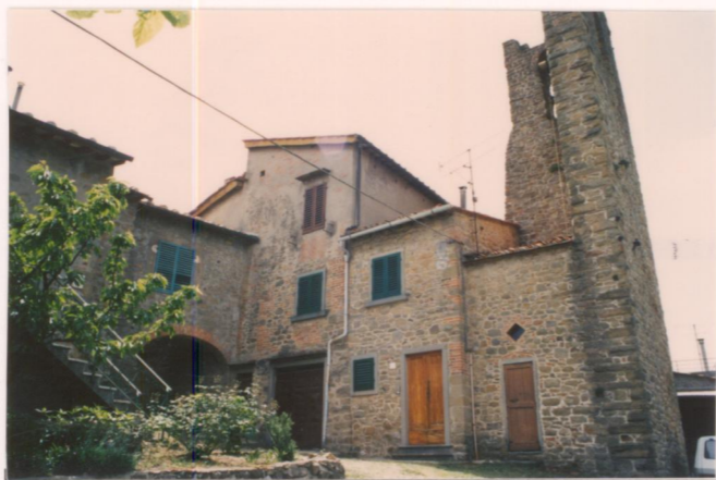
p.v. N. 12. Torre del Castello.....
