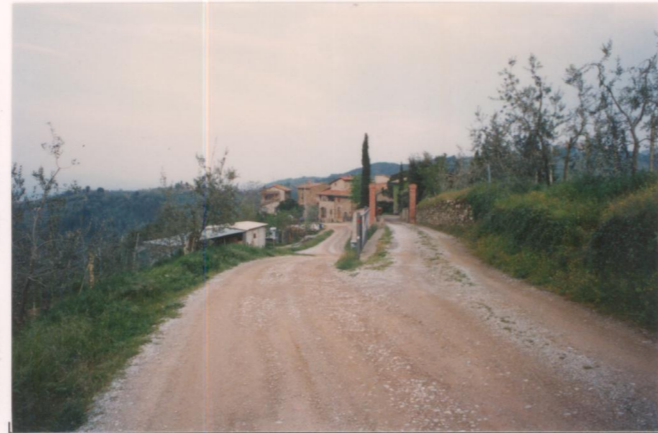
p.v. N. 4. veduta da strada.....
