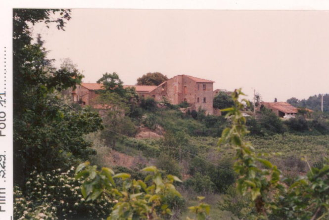
p.v. N.2. Veduta dalla strada (Sud)
