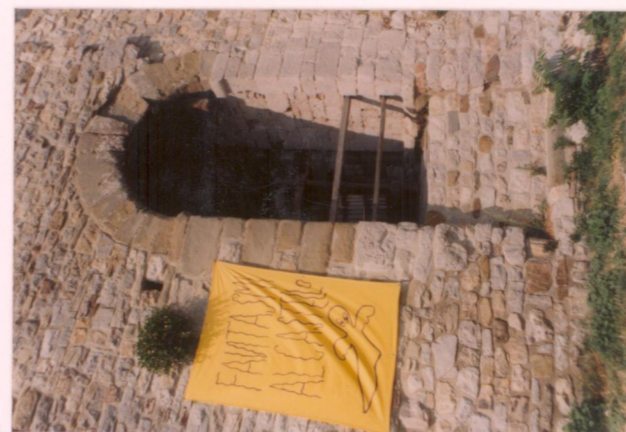
p.v. N. 10. Porta di ingresso al castello
