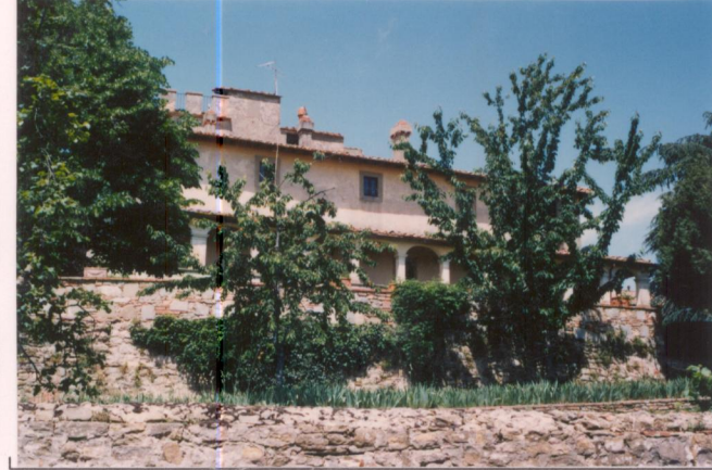
p.v. N. 4. Villa e giardino visti dalla strada.....
