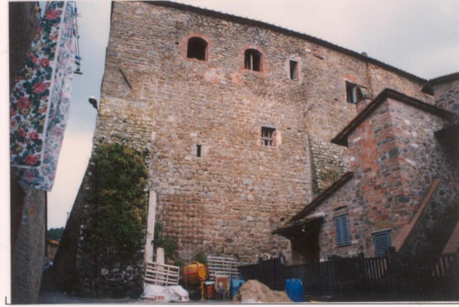
p.v. N. 14... Fronte nord del convento.....
