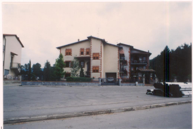
p.v. N. 31. Edificio della nuova espansione a valle (est).....
