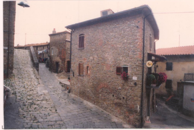
p.v. N. 10... Edifici sotto il nucleo.....
