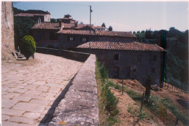
p.v. N. 21 Edifici esterni alla cinta.....
