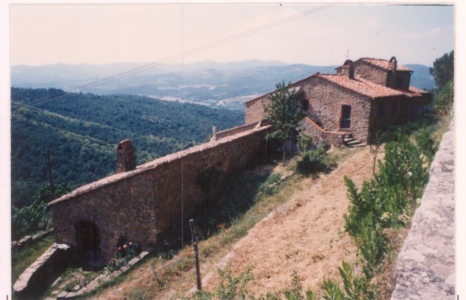
p.v. N. 20 Edifici esterni alla cinta.....
