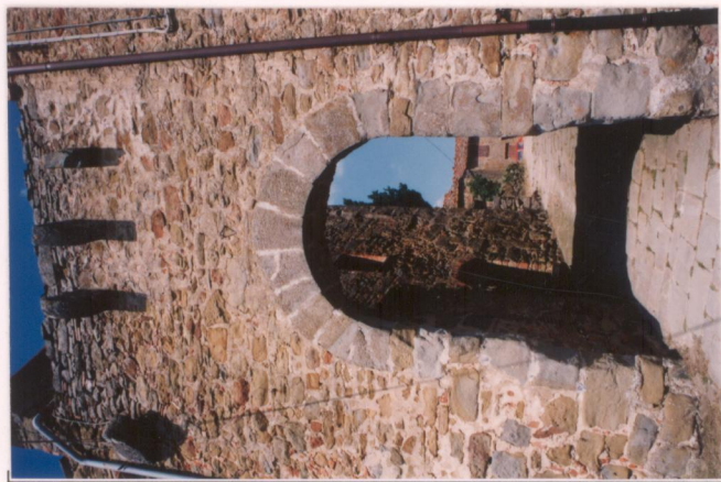
p.v. N. 15 Porta di ingresso al castello.....
