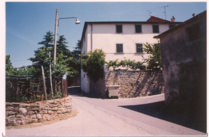
p.v. N. 18 Ingresso da sud.....
