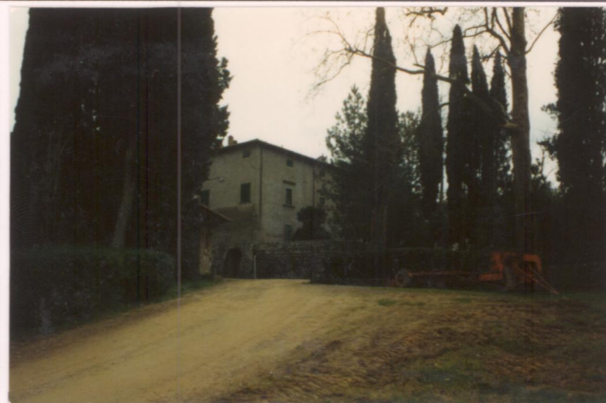
p.v. N. 9. Accesso alla Villa.....
