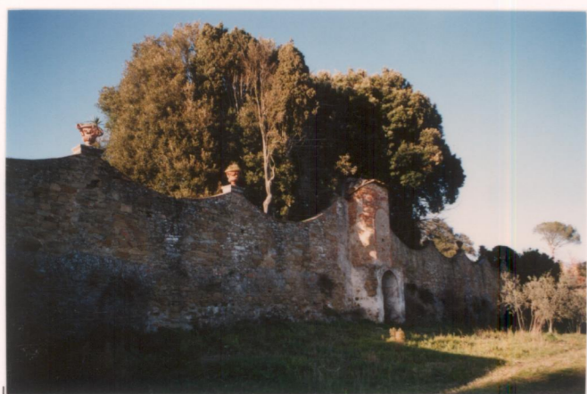
p.v. N. 11... Muro di recinzione del giardino interno .....
