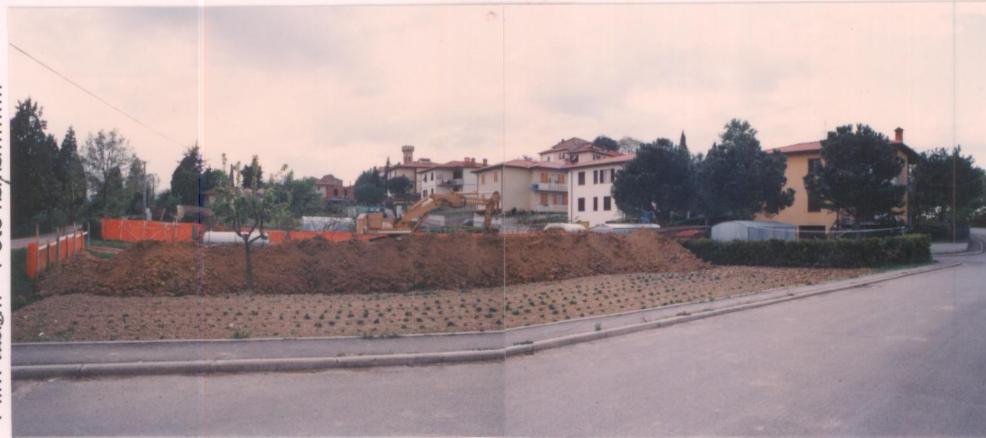
p.v. N. 4. Area di nuova espansione.....
