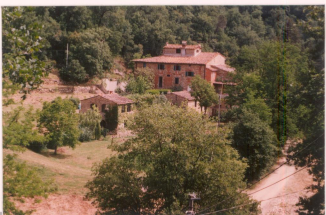
p.v. N. 15. Edificio sotto Pogi vicino all'Ambra mulino.....
