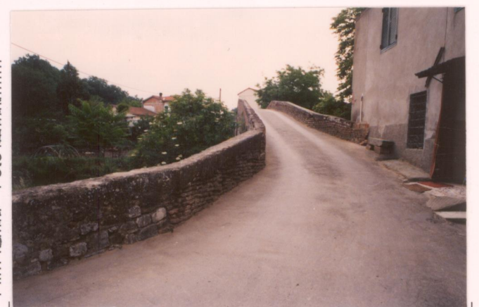
p.v. N. 10. Ponte di Pogi.....
