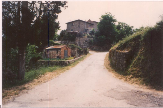
p.v. N. 4 Strada di accesso all'aggregato.....
