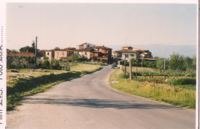
p.v. N. 2. Veduta da S. Reparata
