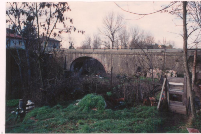
p.v. N. 2... Il ponte sul T. Castro
