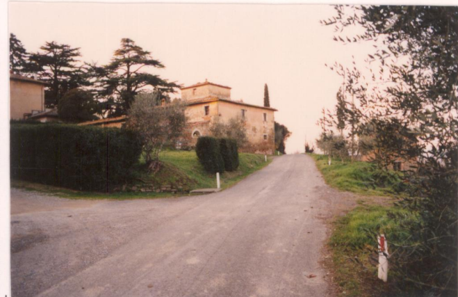
p.v. N. 5...Edifi rurali...del complesso...Villa Fabbriche
