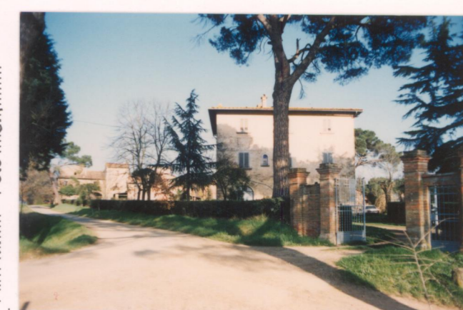
p.v. N. .18.: Pod. Capannone.....
