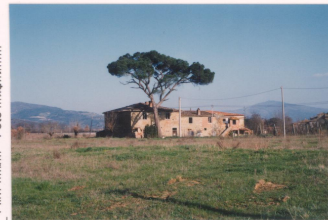
p.v. N. .14.: Stradalella.....
