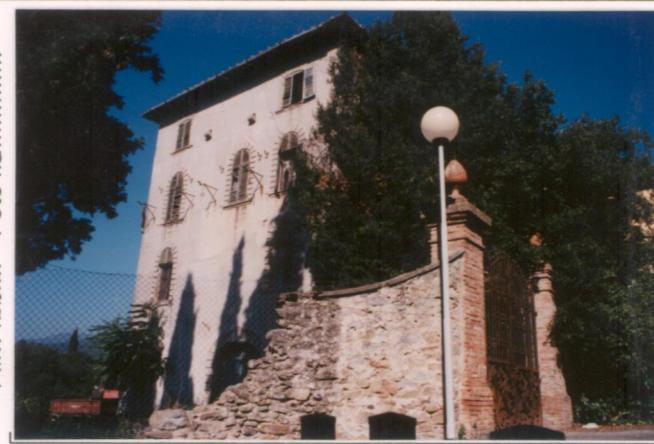
p.v. N. 3. Facciata sud
