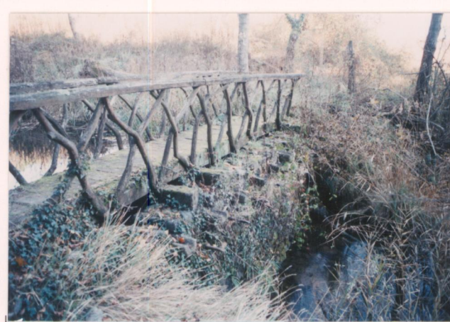
p.v. N. La passerella sul laghetto
