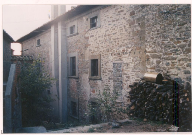
p.v. N. 13 Il fronte nord-est della villa
