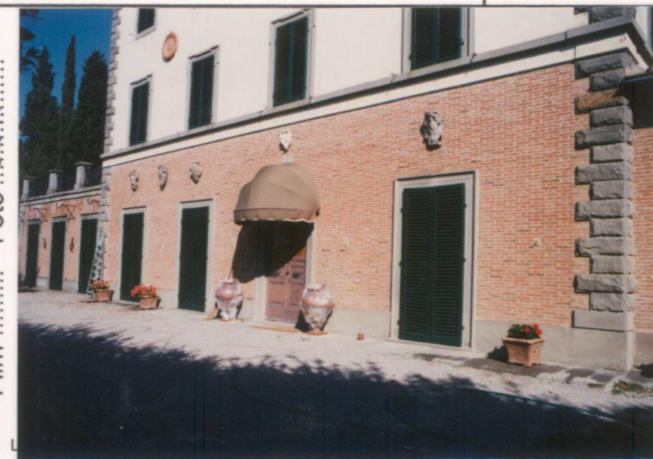
p.v. N. 3... Particolare del fronte principale.....
