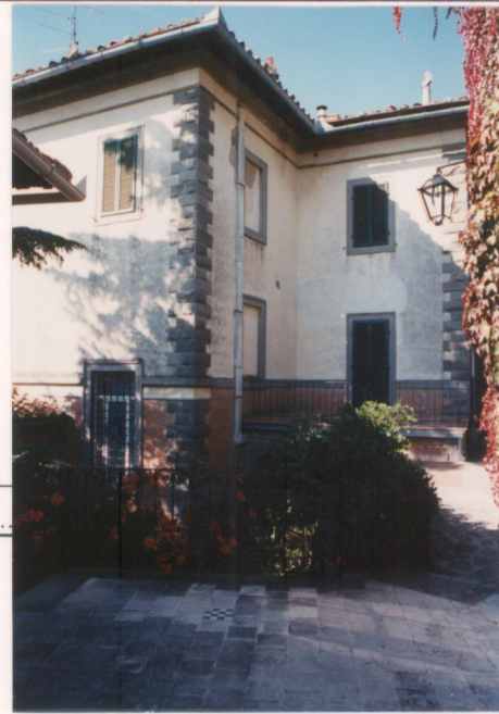
Angolo interno del corpo della villa.
