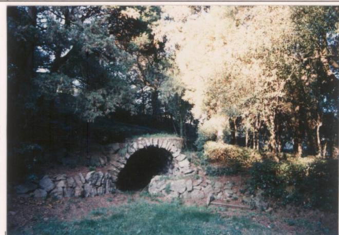
p.v. N. 16. Sistemazioni idrauliche del laghetto non più esistente
