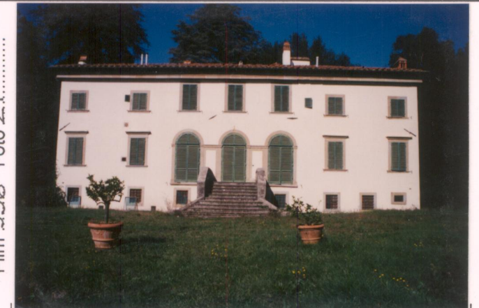
p.v. N. 3. Facciata.....
