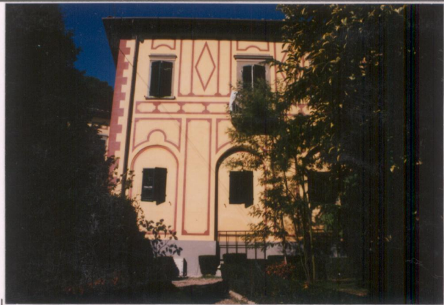
p.v. N. 5. Particolare del fronte sud.....
