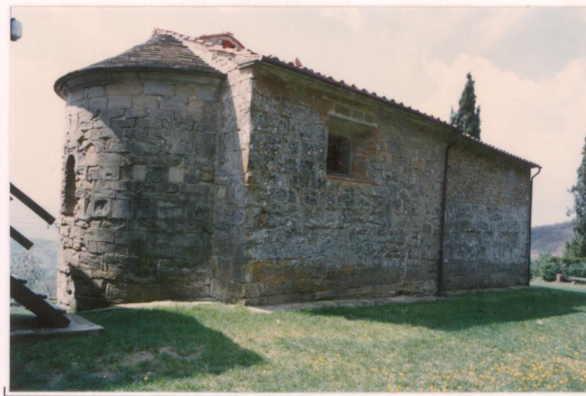
p.v. N. 9. La parte absidale della chiesa.....
