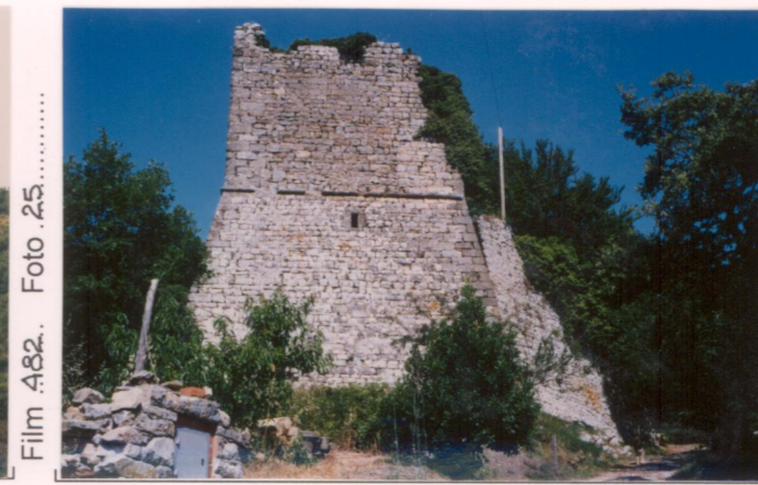
p.v. N.2...La Torre - Pod. Migliariccio.....
