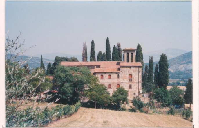
p.v. N. 2 ....Dalla strada per Campalla.....
