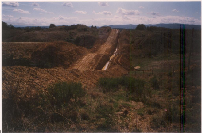
p.v. N.14 Trincea metanodotto verso Est.....
